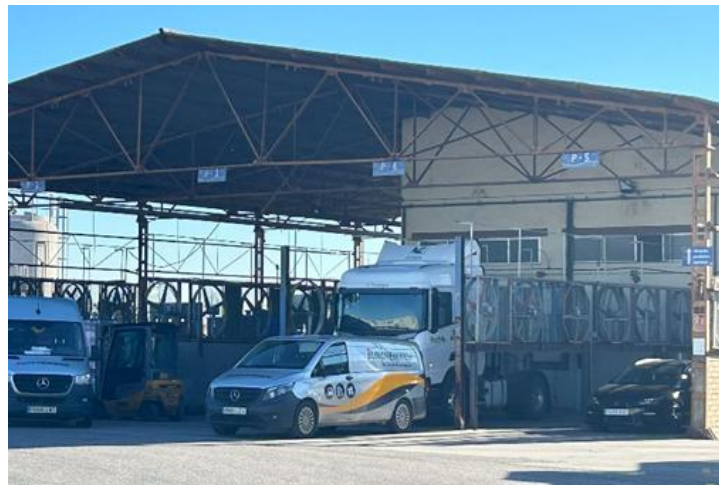
Aire d'attente des camions ventilée (PADESA, Amposta)
