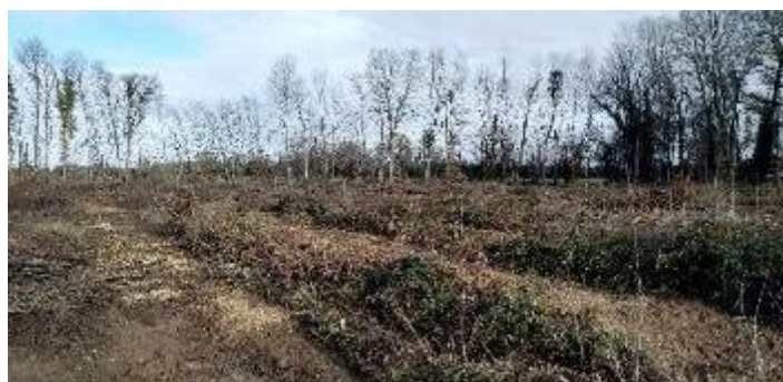
Chantier de reboisement en cours avec l'aide France Relance
