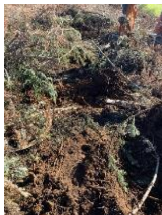
Photo du chantier en cours
