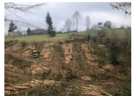
Photo de la parcelle après le chantier France Relance
